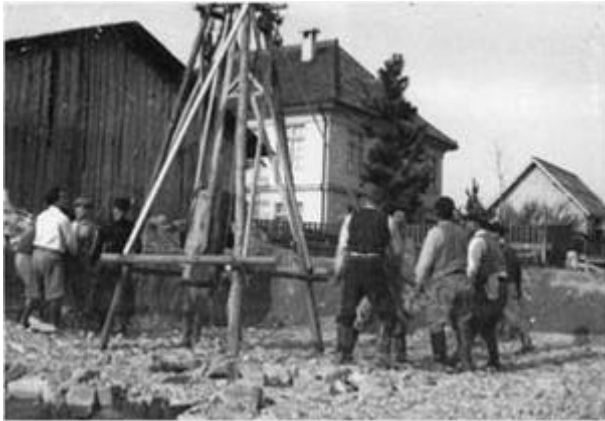
(地盤改良工事 清水建設提供)
