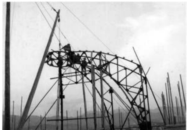
(ドームの鉄骨組み立て 清水建設提供)
