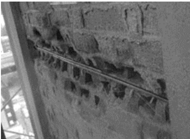
(塔のコンクリート煉瓦劣化部を除去した様子)
