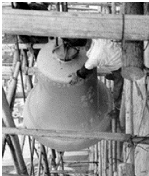
(塔に吊り上げられる平和の鐘)
