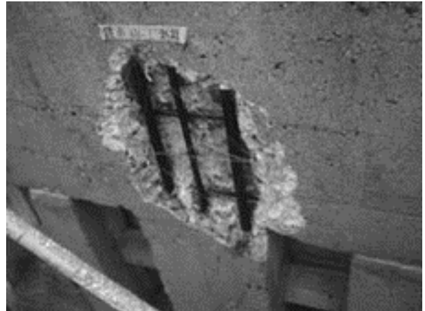
(鉄筋が錆びて剥離したコンクリートを除去した様子)
